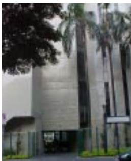
Entrada principal do Fórum
