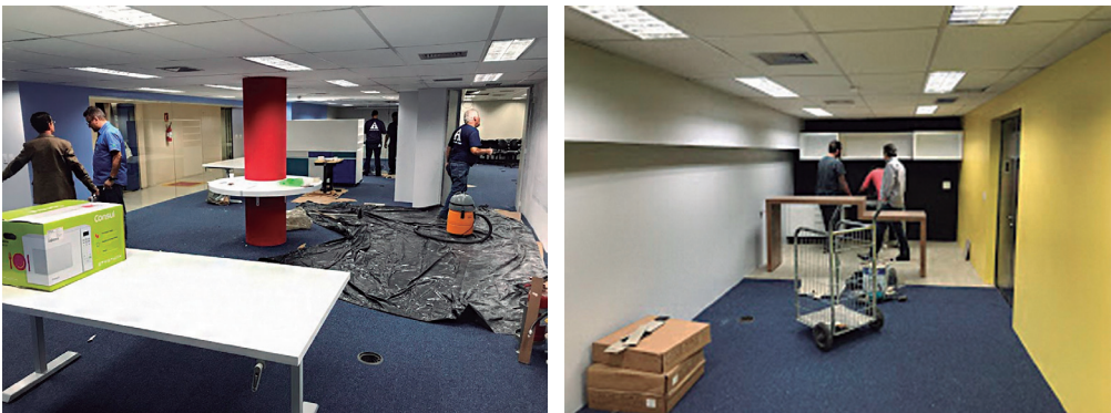
Figura 2. Fotos da reforma.
