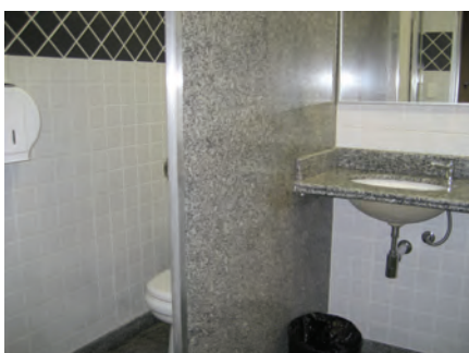
De cima para baixo: obras no 12º andar do JEF-São Paulo devido ao incêndio em 2007, reforma do telhado em Santos e banheiros reformados no Fórum de Execuções Fiscais da Capital.
